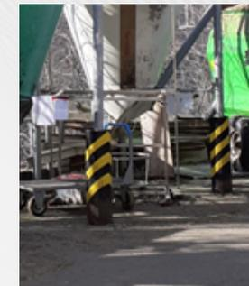
Controllare il corretto serraggio dei bulloni e la stabilità delle colonne di sostegno e non rimuovere protezioni fisse e/o dispositivi di sicurezza; Devono essere installate protezioni contro urti dei mezzi nelle fasi di carico/scarico (in particolar modo se dotati di 3 pali di sostegno) per evitare il ribaltamento del silos stesso
