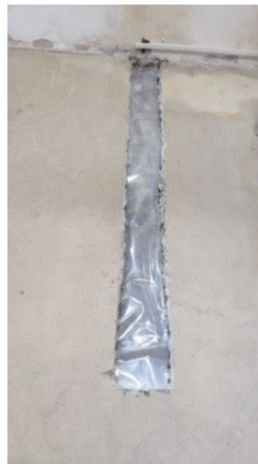
FASE 3 Copertura con telo da cantiere
