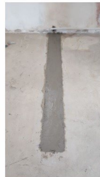
FASE 4 Ripristino della pavimentazione
