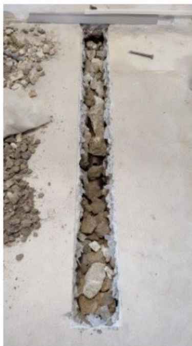
FASE 2 Riempimento con pietrame/ghiaione
