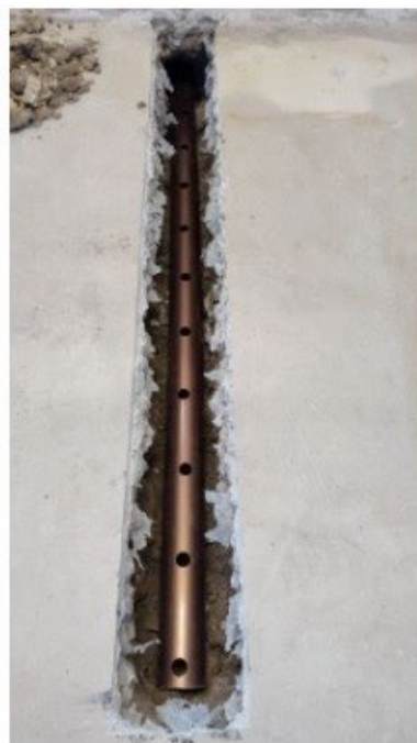
FASE 1 Scavo e alloggiamento della tubazione in pvc forata
